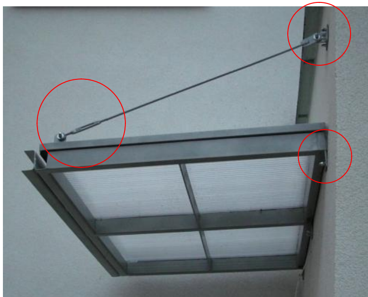
Rys. 2. Przykład mocowania daszku do ściany.
