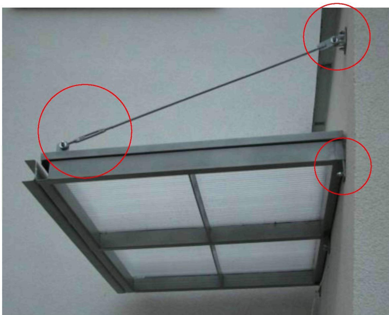
Rys. 2. Przykład mocowania daszku do ściany.
