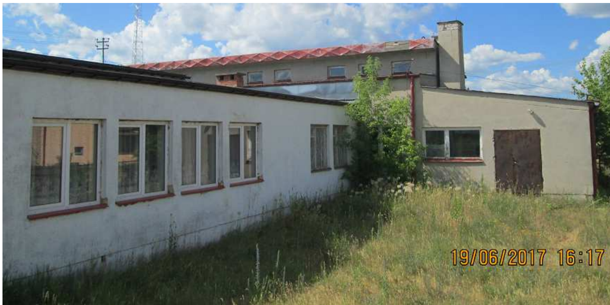
Widok budynku od strony wschodniej i południowej
